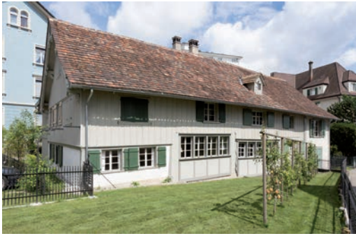
Die Denkmal Stiftung Thurgau hat die Fischerhäuser an der Mittleren Gasse 11 in Romanshorn fachgerecht restauriert
