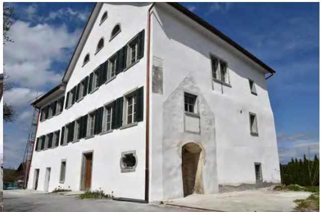
heute, nach der Sanierung
